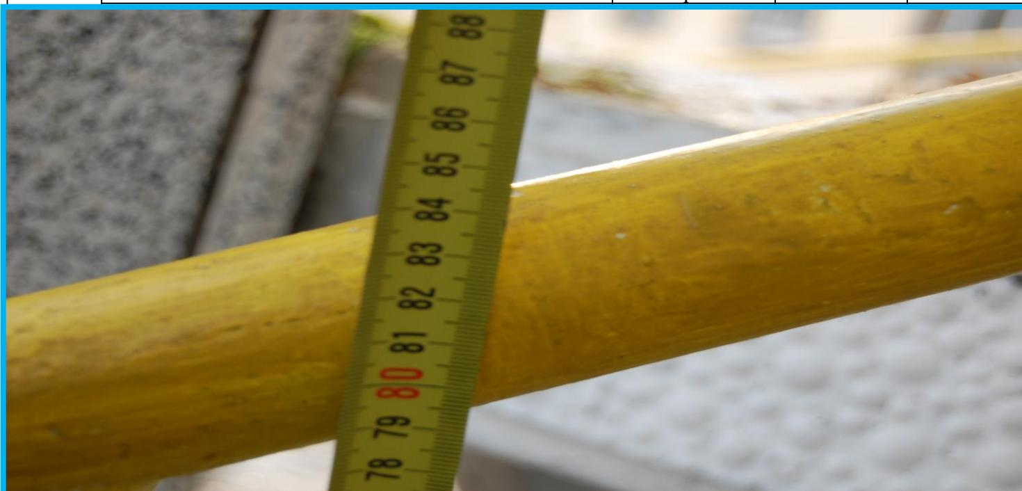
5.3.4 Высота охватываемой поверхности лестничного поручня над наплывом лестничной ступени должна быть, мм:
